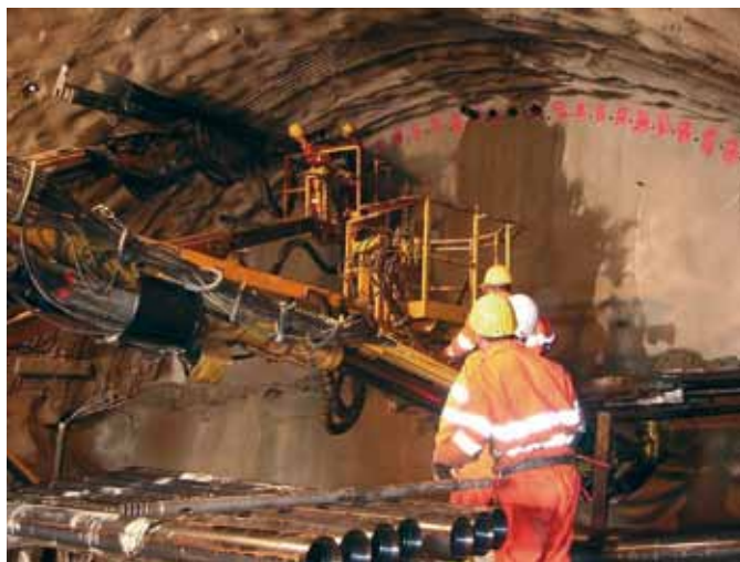
Tunnelausbruchmaterial als Forschungsobjekt
