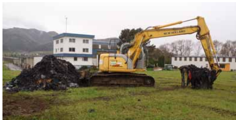
Eine Deponie wird aufgegraben.
