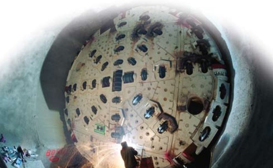
Mit solchen Vortriebsmaschinen wird tief in den Berg vorgedrungen. Bei dieser Arbeit kommt eine riesige Menge an Material zum Vorschein.
