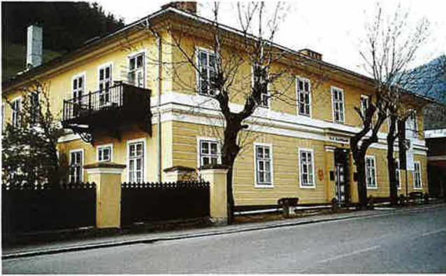
Bild 5: Raithaus in Vordernberg, erbaut 1839/40. Lehrgebäude der Montanlehranstalt. FOTO WILKE Leoben.
