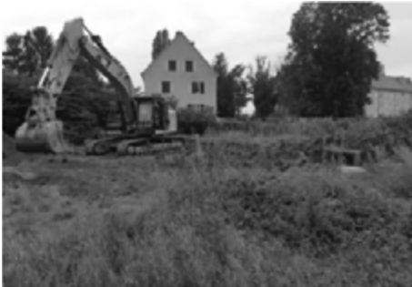
Abb. 5: Brachfläche mit abzubrechendem Gebäudealtbestand (RM Umweltkonsulenten ZT GmbH, 2020)
