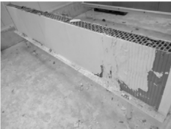
Abb. 3: Musterwand aus Hochlochziegeln und Gipsputz
