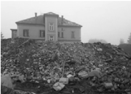
Abb. 7: Abbruch und zu erhaltendes Gebäude (RM Umweltkonsulenten ZT GmbH 2020)
