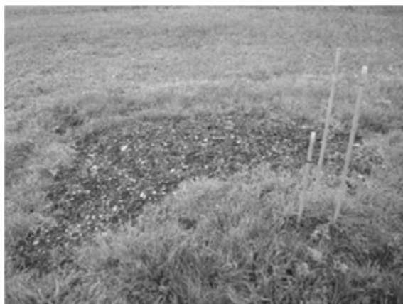
Abb. 2: Vegetationsschaden im Randbereich (Hotspot) des Fensters 1, wo das Gasdrainagerohr des ehemaligen Gasbrunnen eingeleitet wird
