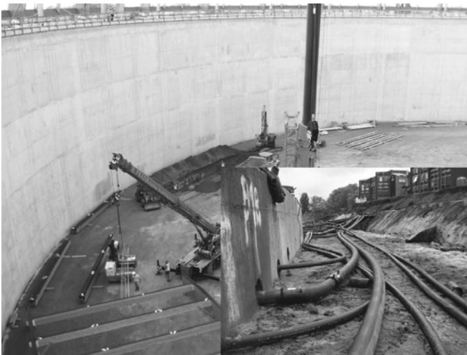
Abb. 2: Leitungsführung unter das Bauwerk (Quelle: PWT, Arcadis).
