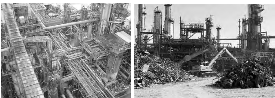
Abb. 2: Rückzubauende Rohrleitungstrassen und Anlagendemontage.
