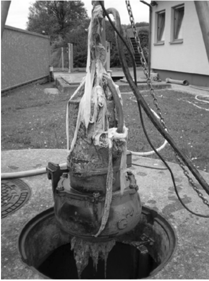
Abb. 1: Problematik von FT in einer Rechenanlage (rechts oben), bei der Verstopfung von Pumpen (links) und technischen Einrichtungen von Klärbecken (rechts unten).
