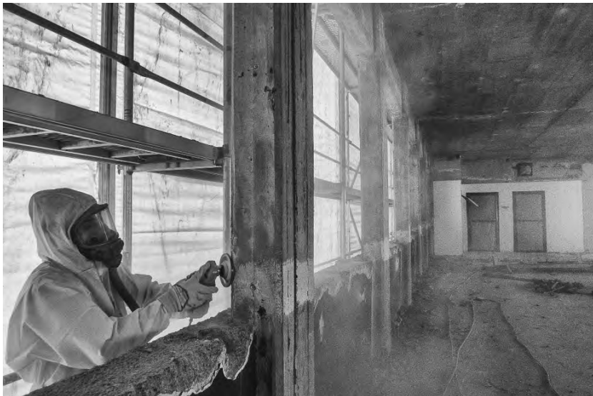
Abb. 2: Arbeiten innerhalb der Zone – Reinigung der Betonflächen.
