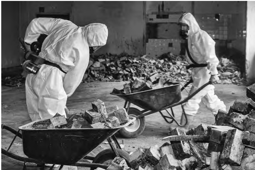
Abb. 3: Ausbau des PAK – haltigen Holzstöckelbodens.
