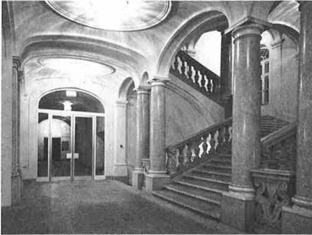
Bild 7: Hauptstiege des Hauptgebäudes. FOTO RADERBAUER/Leoben.
