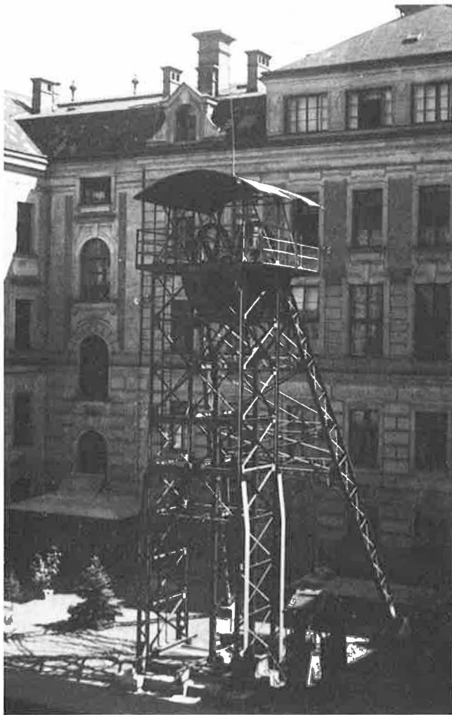
Bild 8: Innenhof mit Förderturm.
